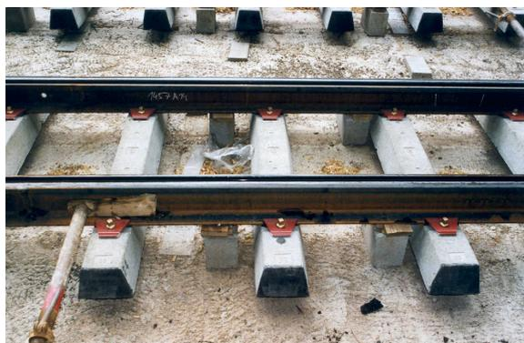
Terrassement, réglage fond de fouille, puis calage des rails au moyen de plots ciment; mise en place des nouvelles traverses et réglage en altitude et dévers à l'aide de coins en bois avant bétonnage.
