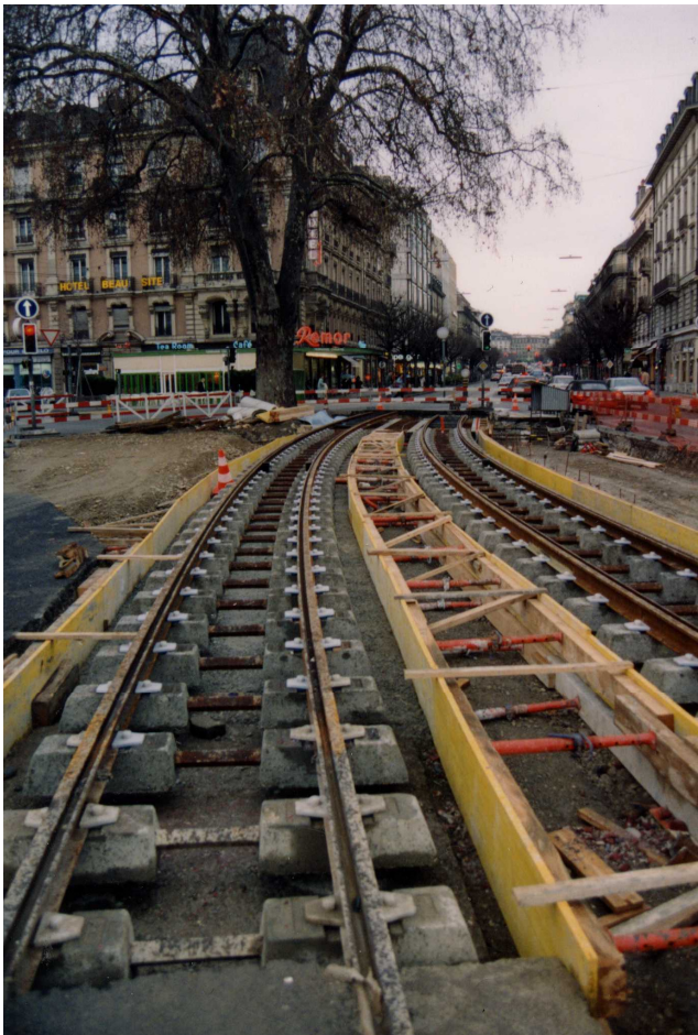
LIGNE 13 - Place du Cirque (traverses bi-blocs)
