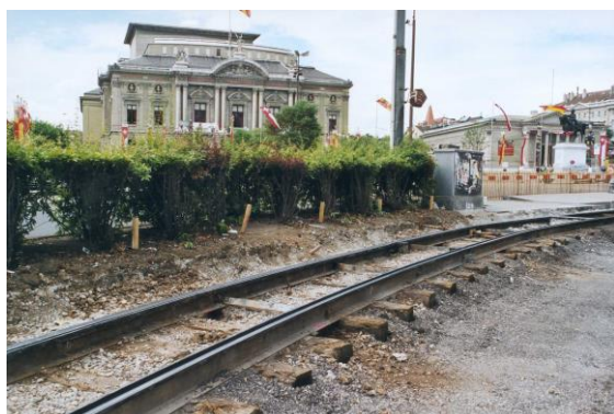
Anciennes traverses bois à déposer
